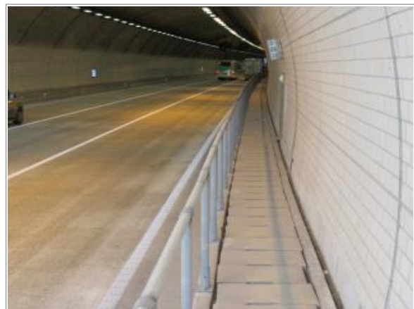
공동구 및 배수로 전경(주행선측)
