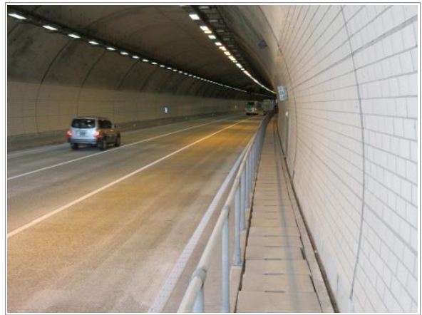
측벽부 타일마감 전경(주행선)
