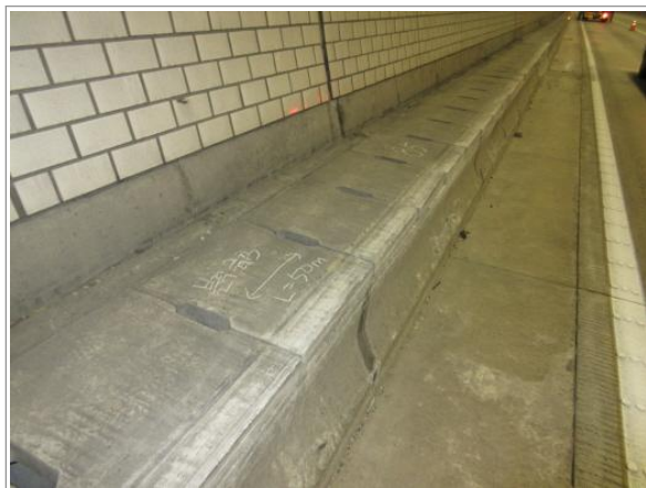
공동구 및 배수로 전경(추월선측)
