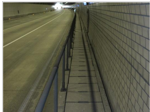
공동구 및 배수로 전경(주행선측)
