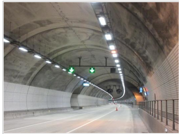
터널 내부 전경
