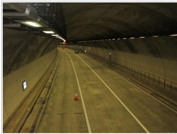
터널 내부 전경
