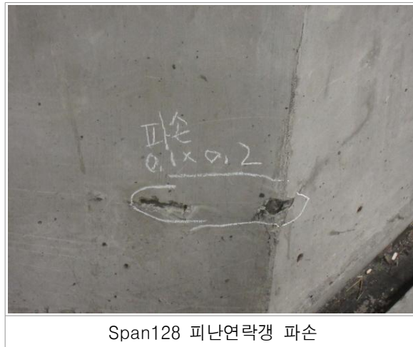
〈사진 3.28〉 피난연락갱(포항) 외관조사 현황
