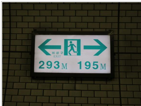
비상구안내 표지판 전경
