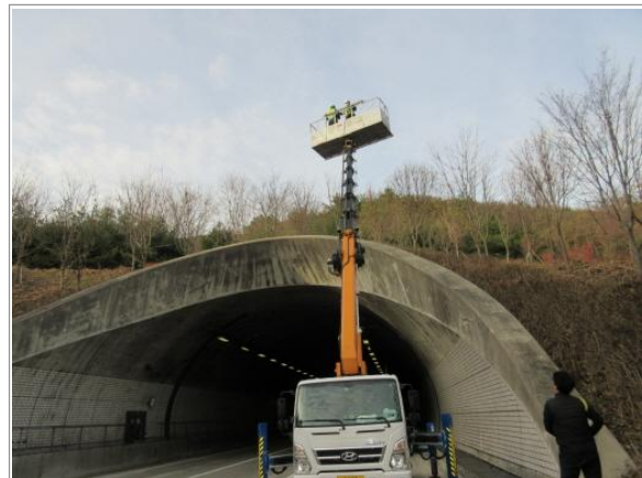
고소작업차를 이용한 조사 전경 ②
