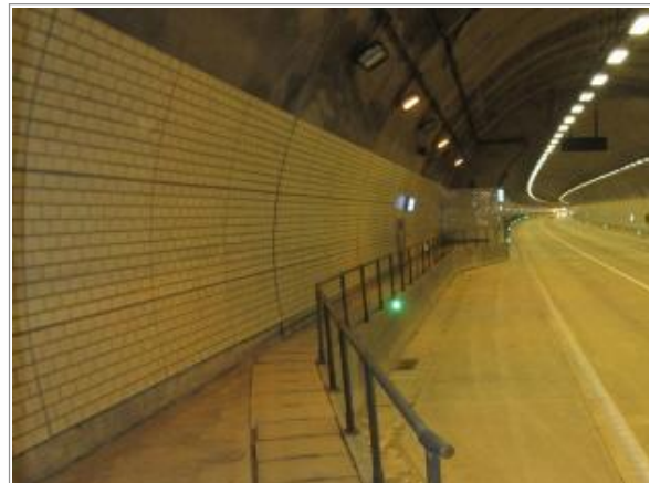
측벽부 타일마감 전경(주행선)
