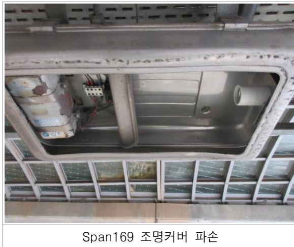
〈사진 3.15〉 터널 부속시설(부산) 외관조사 현황
