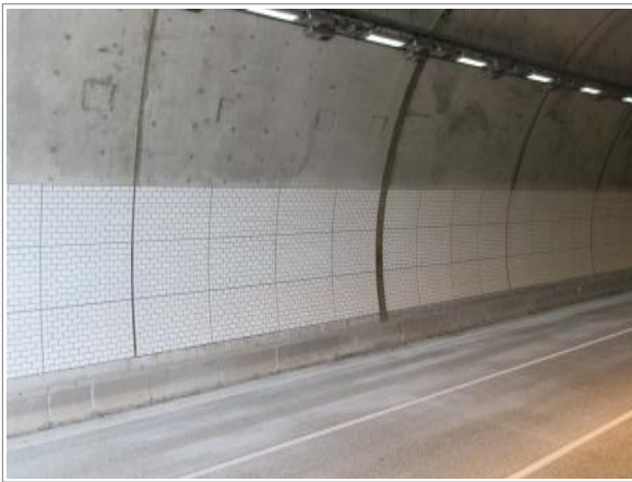
측벽부 타일마감 전경(추월선)
