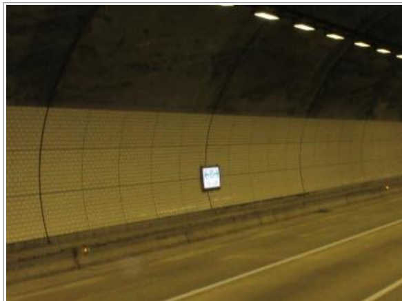
측벽부 타일마감 전경(추월선)
